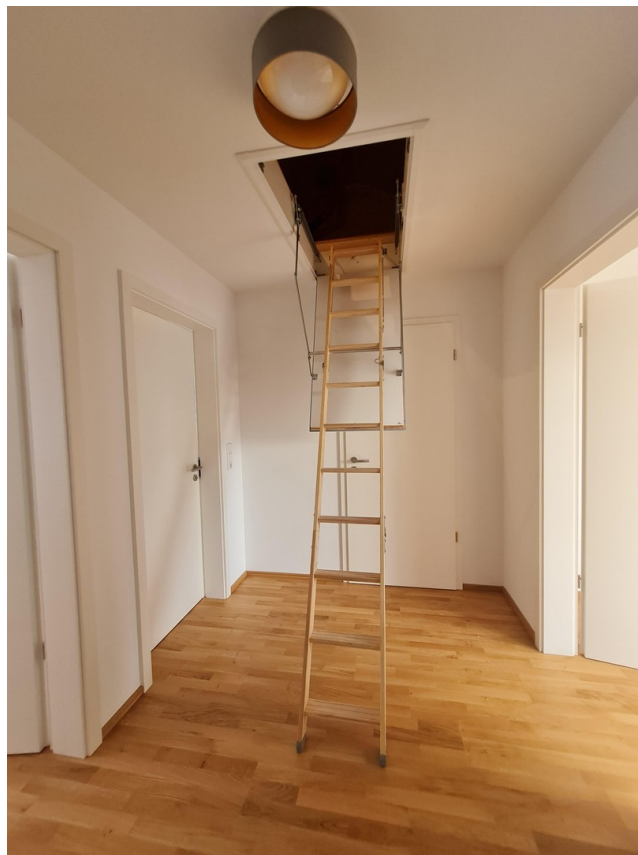
OG Einschubtreppe zum DG
