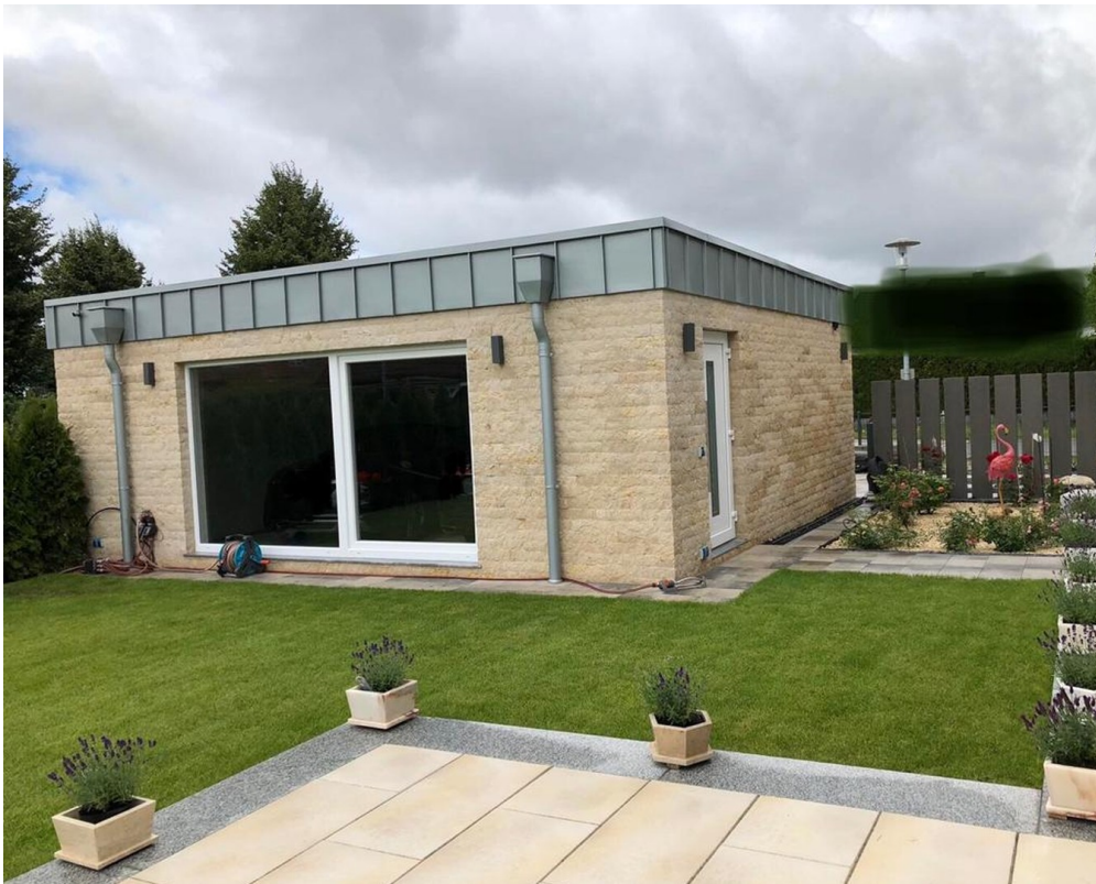
Garage II / Rückansicht
