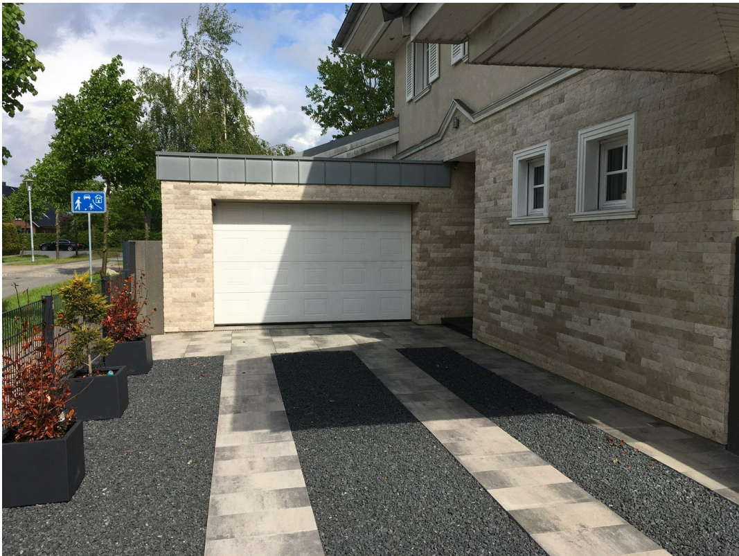
Garage I / Auffahrt
