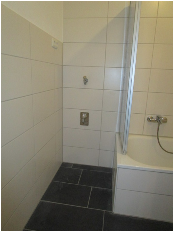
Bad Waschmaschinenanschluss
