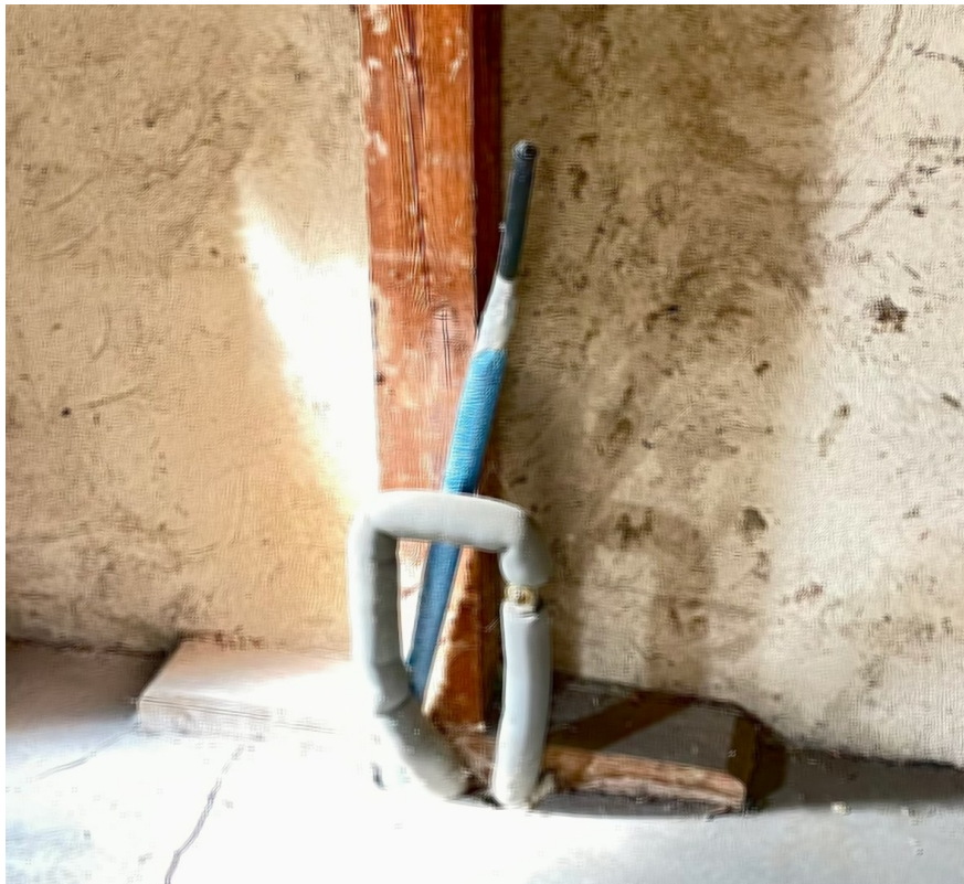
Anschlüsse für Dachwohnung
