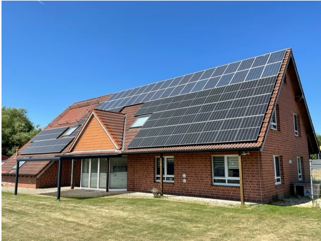
komplette Gebäudeansicht vorne
