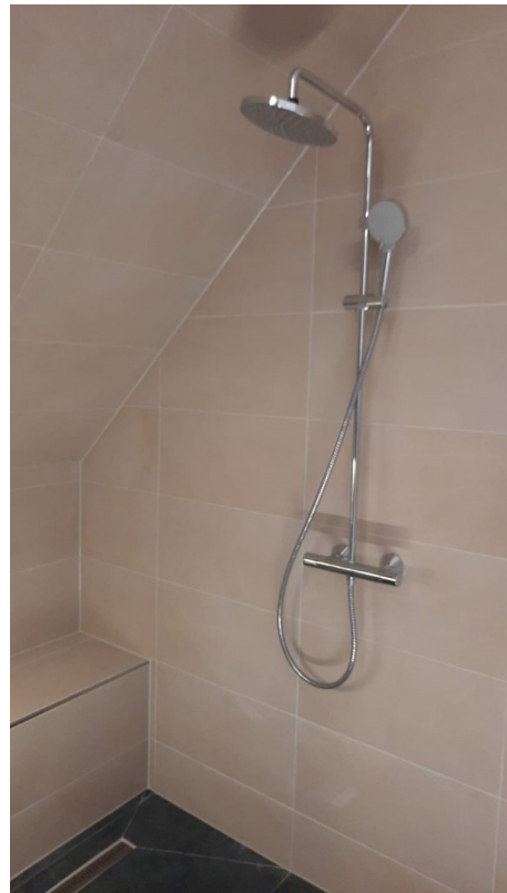
Dusche im OG
