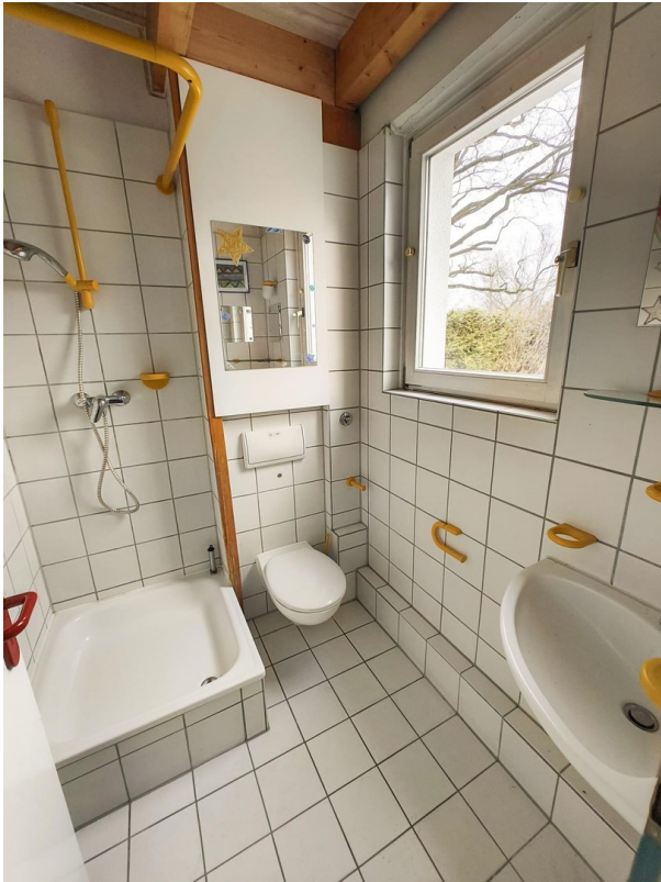
EG Gäste WC mit Dusche
