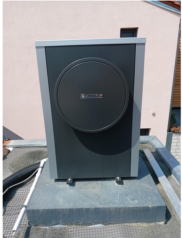
Wärmepumpe (Außeneinheit)
