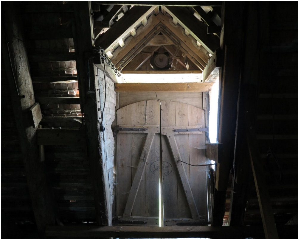
eines der beiden Krantore DG
