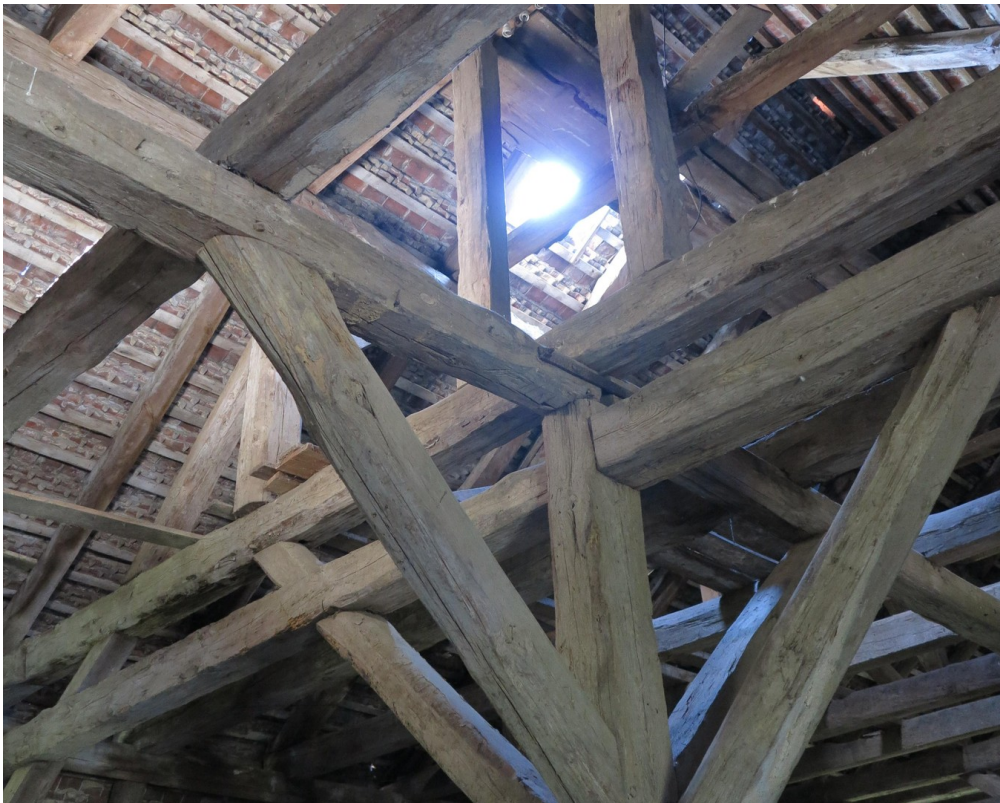
Ständerwerk DG & Spitzboden
