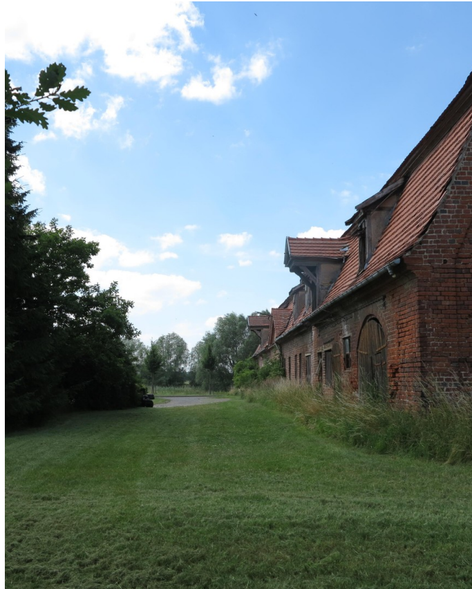
unter d.Rasen liegt d.Pflaster
