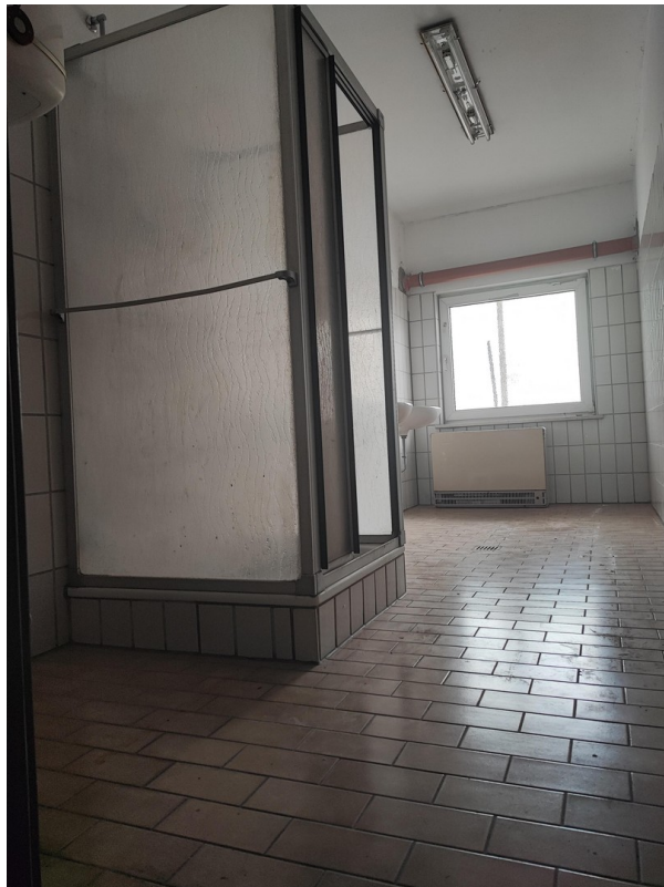
Sanitär mit Kleinlager
