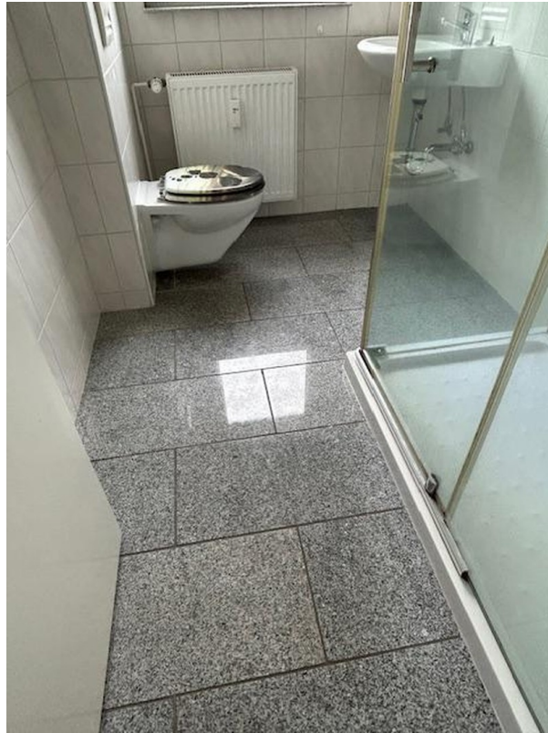
Granitfliesen im Bad
