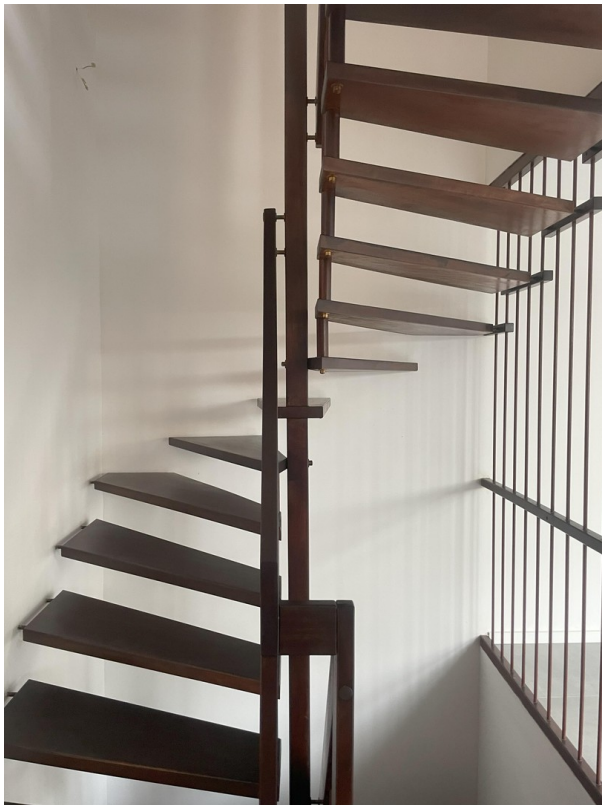
Treppenaufgang vom EG zum 1.OG
