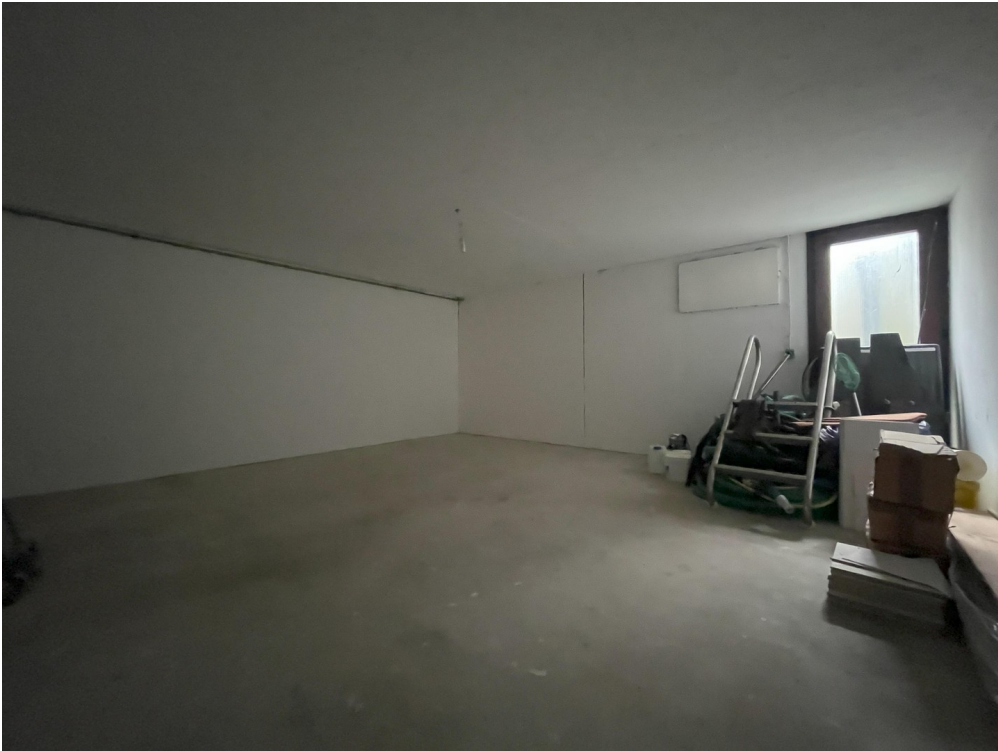
Keller mit Treppe zum Garten
