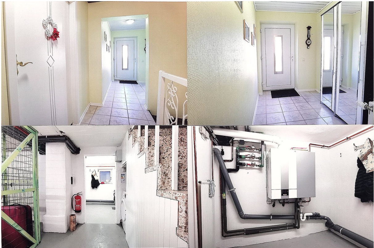
Flur und Keller
