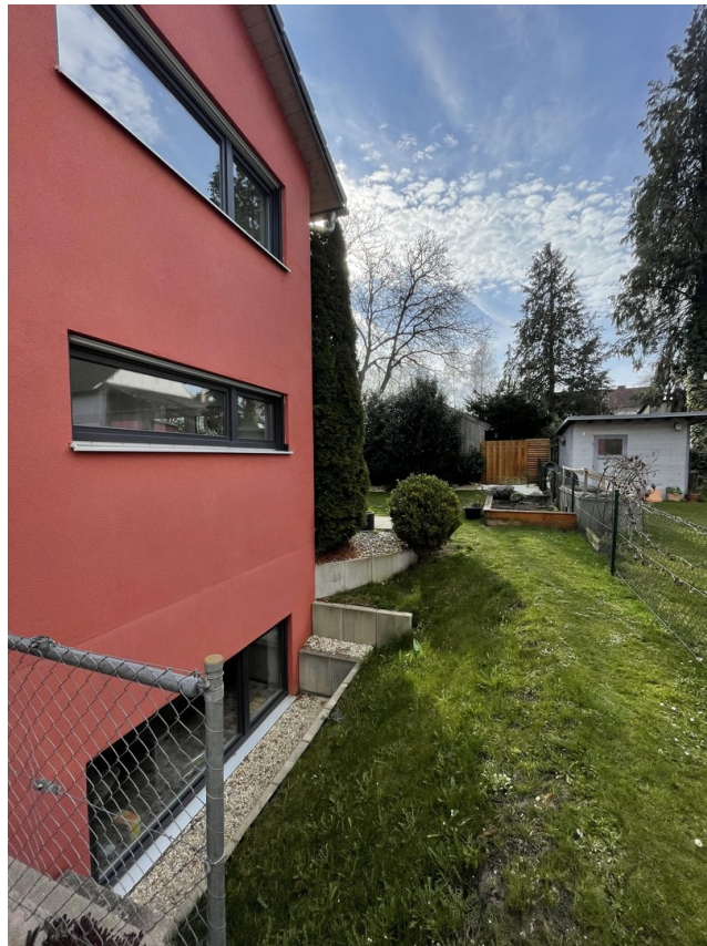
Blick Westseite nach Süden
