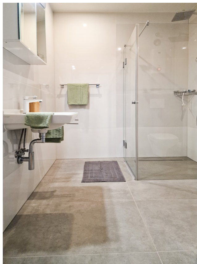
Badezimmer ebenerdige Dusche
