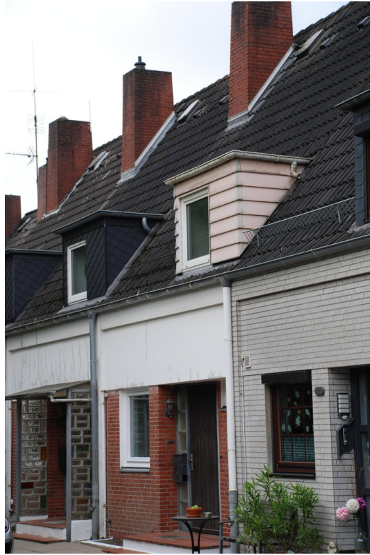
Außenansicht von der Hofseite
