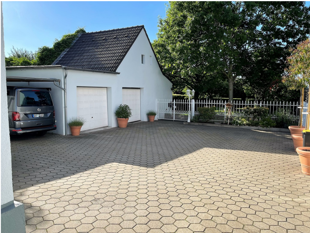
Garagenhof und Carport
