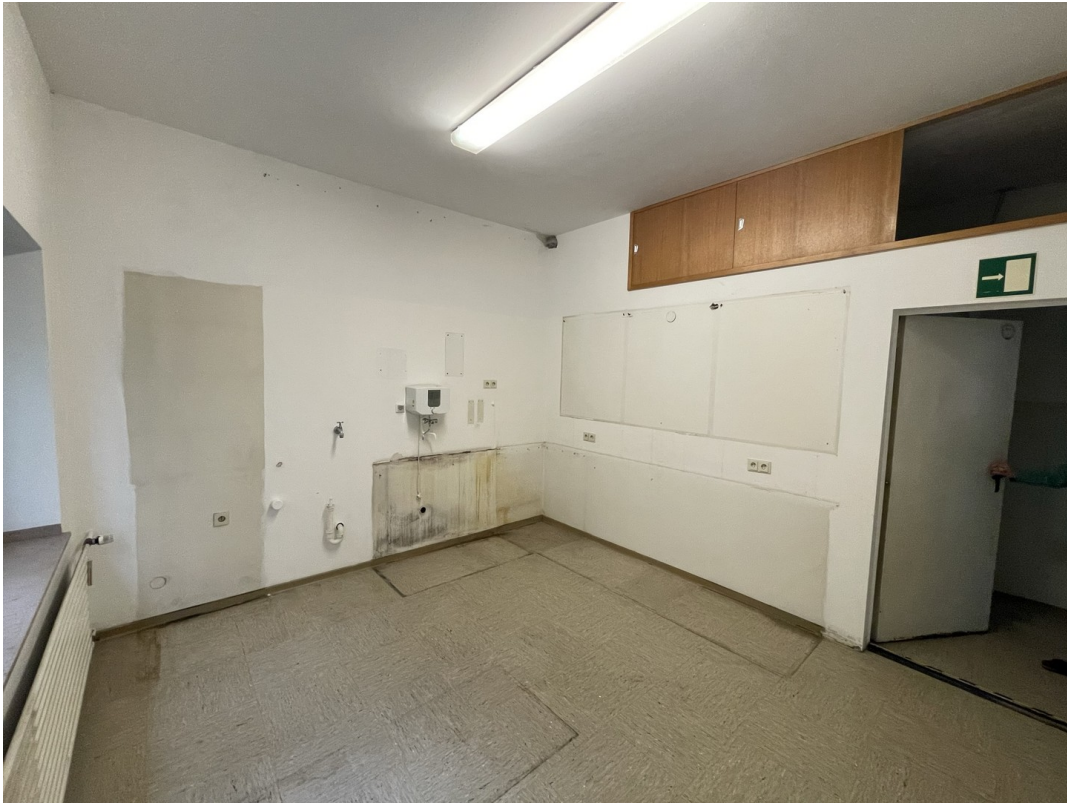
Raum Hinten Rechts / Küche
