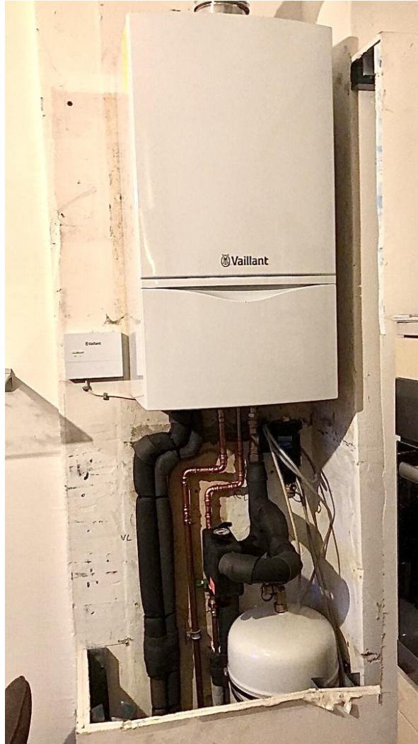
Heizung Dezember 2023 Einbau
