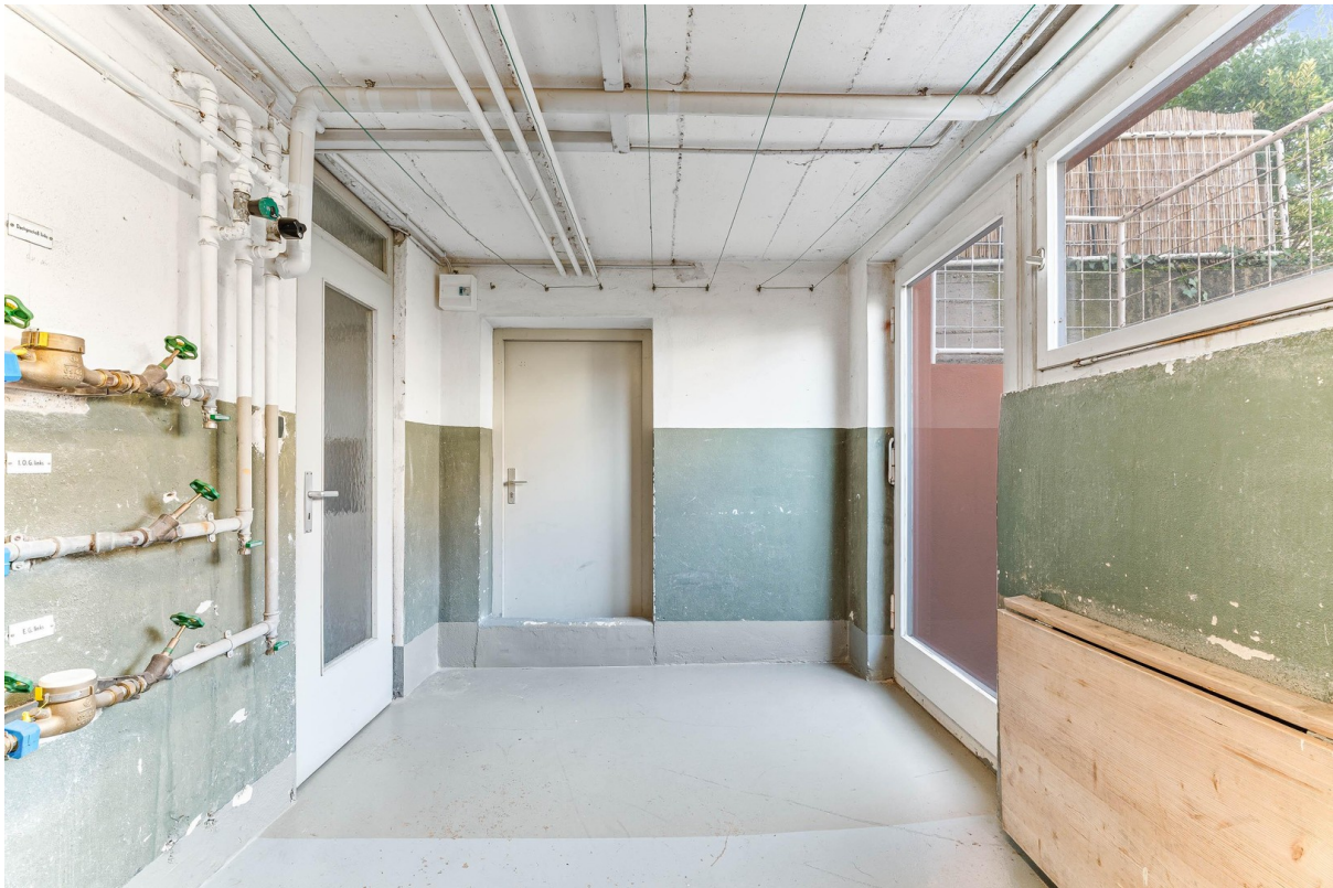
Zugang zum Keller
