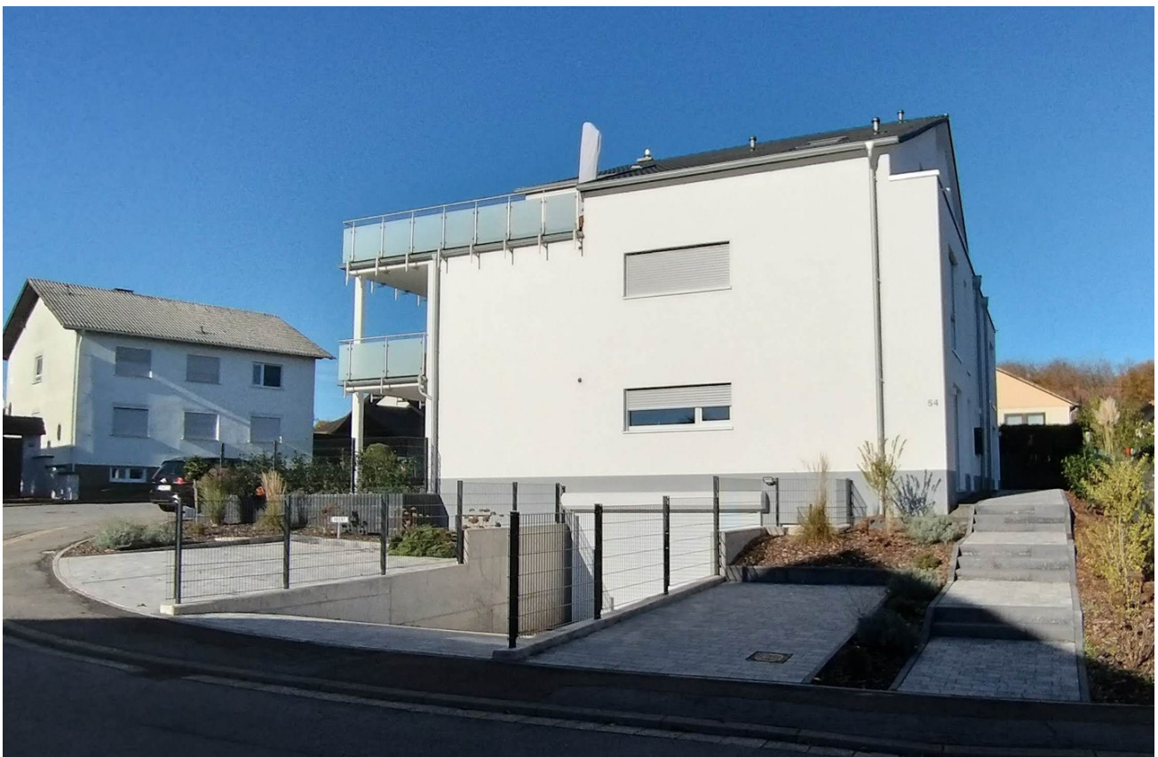
Ansicht Süd-Ost mit Hauszugang
