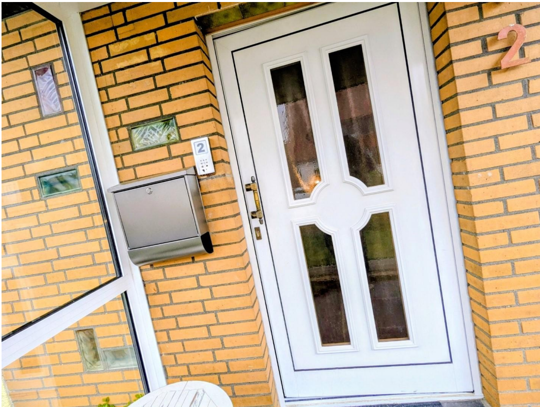
Haustür mit Sprechanlage
