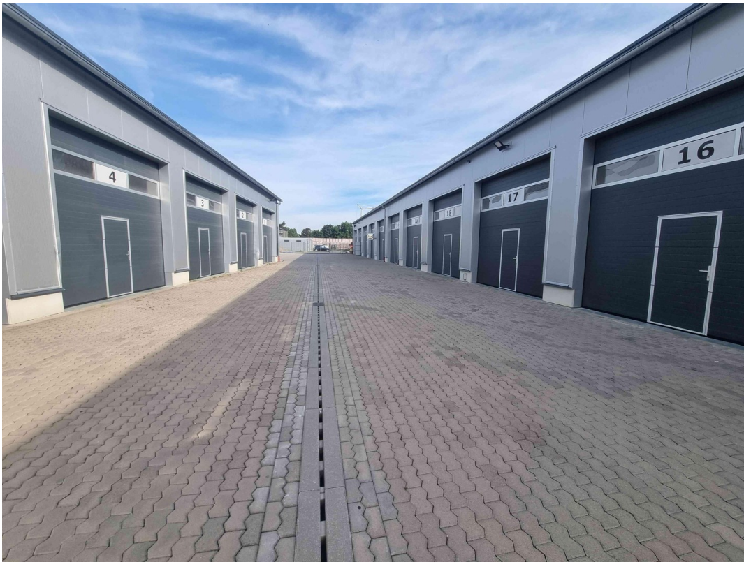
Zufahrt zur Lagerhalle
