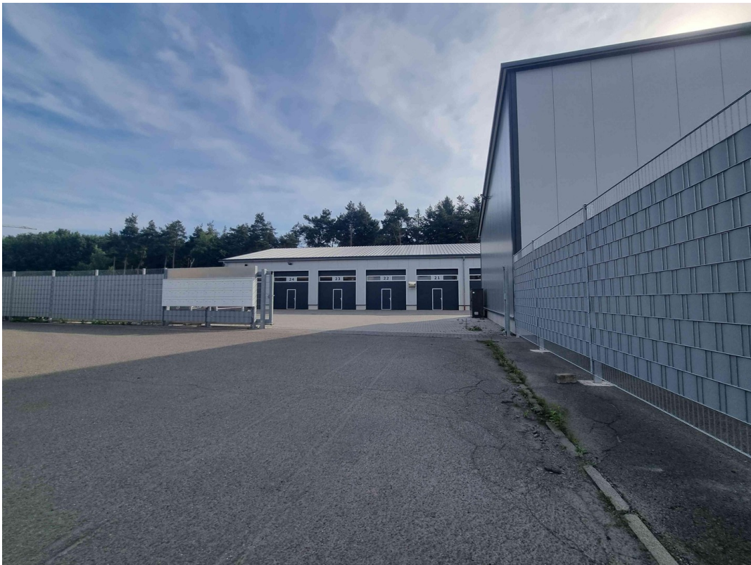
Zufahrt zum Lagerkomplex
