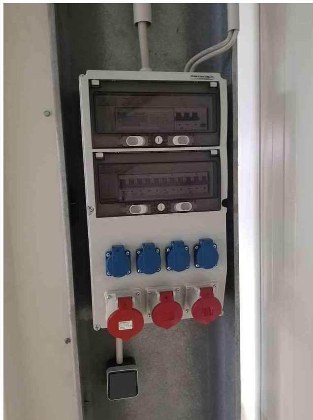
Stromunterverteilung mit Zähle
