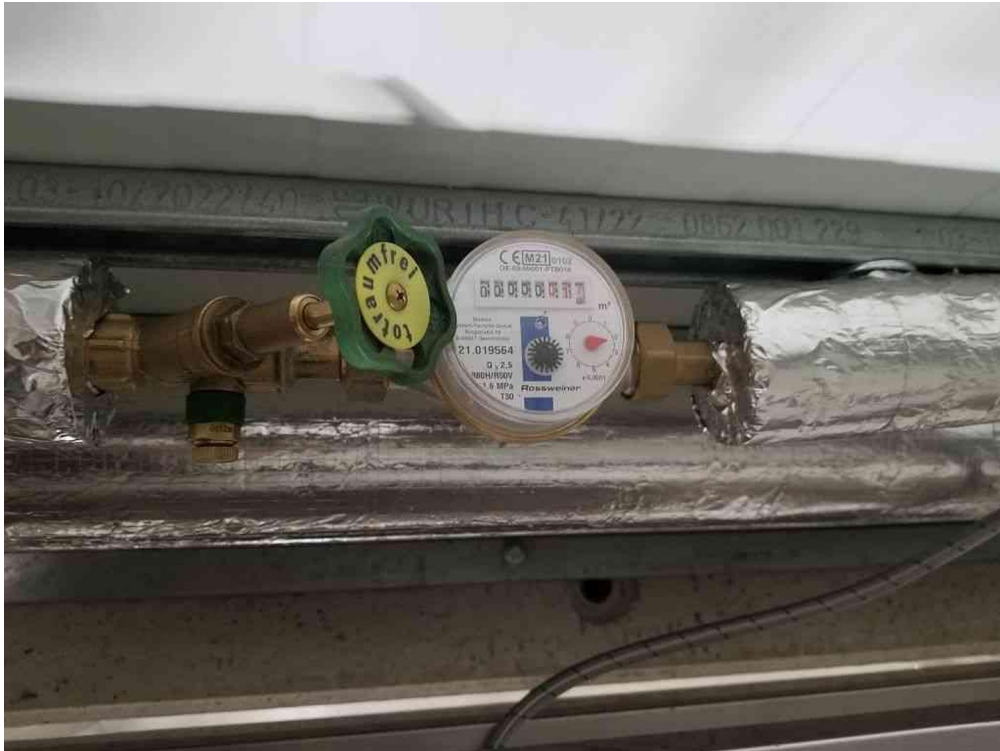
Kaltwasserleitung mit Zähler
