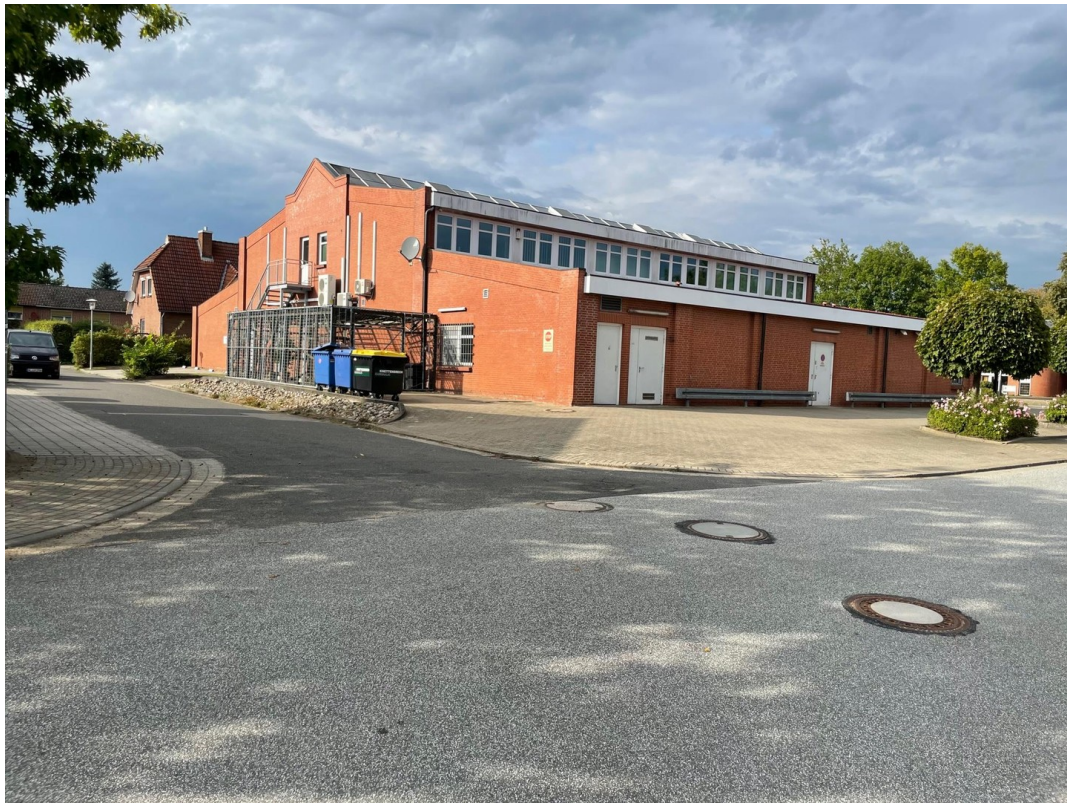
Ansicht von hinten
