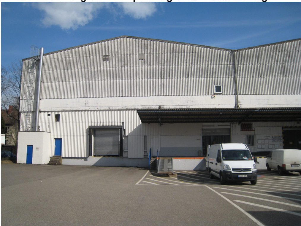
Halle 1 mit vorgelagerter Rampe
