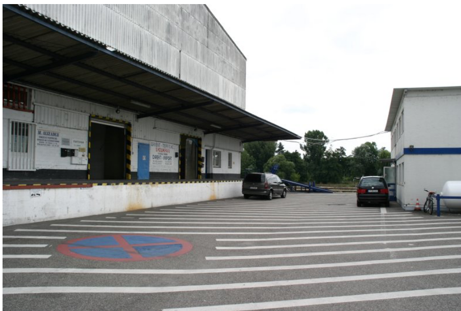
Frontansicht Erdgeschoss mit LKW Rampenandienung
