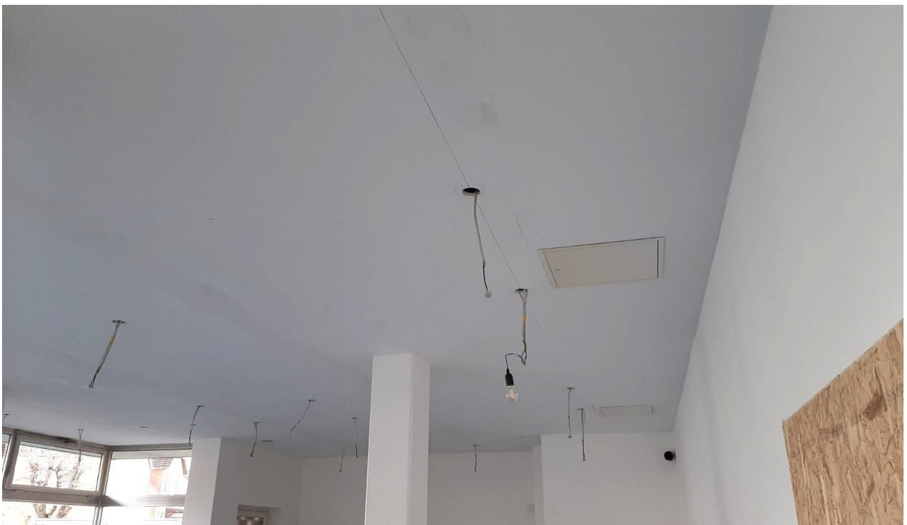
Neue heruntergezogene Decke
