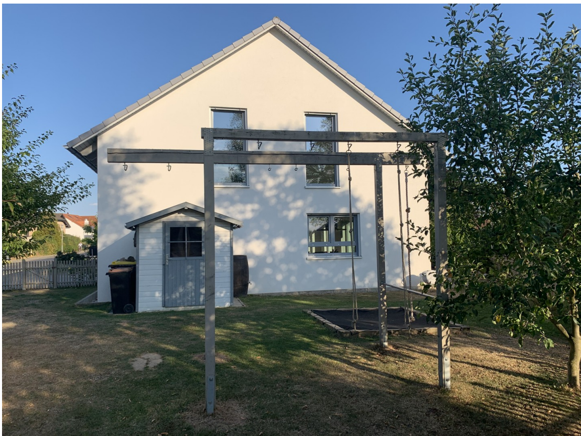
Hausansicht Nord West
