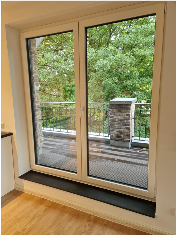
Austritt zur Dachterrasse
