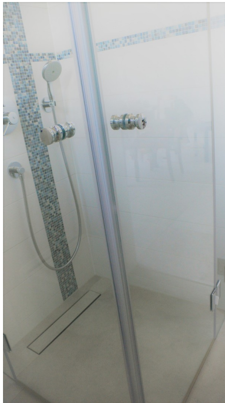
Dusche, Glastür geschlossen
