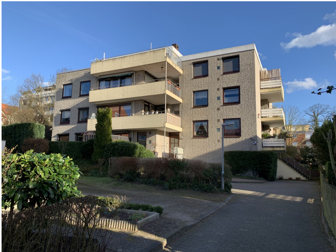
Haus von Außen
