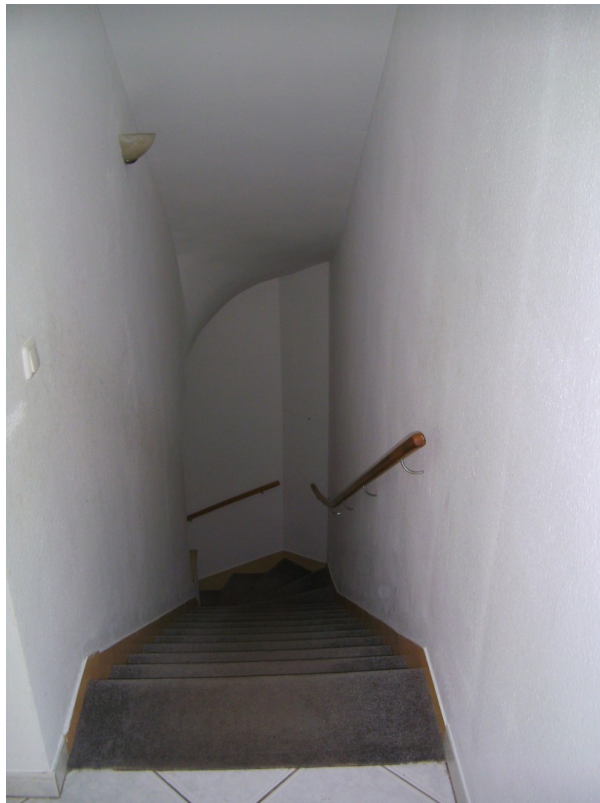
Treppe zum Souterrain
