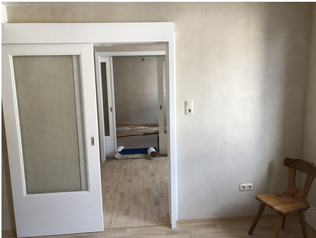
Blick von Küche in Richtung WZ
