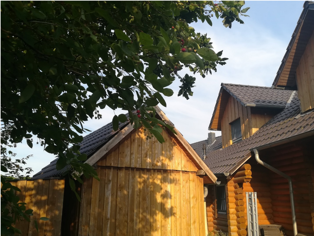
Ansicht Haus und Schuppen
