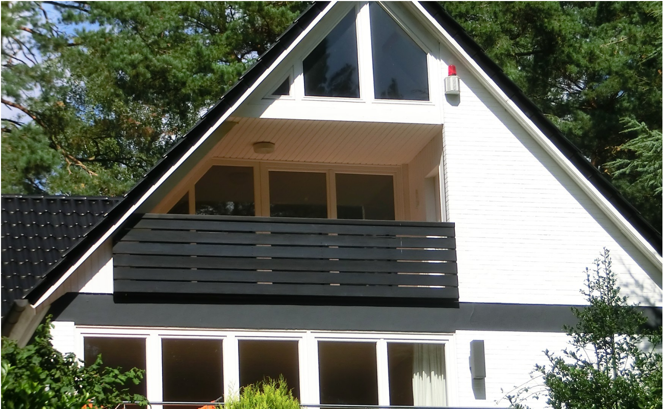
Loggia der Wohnung Südlage
