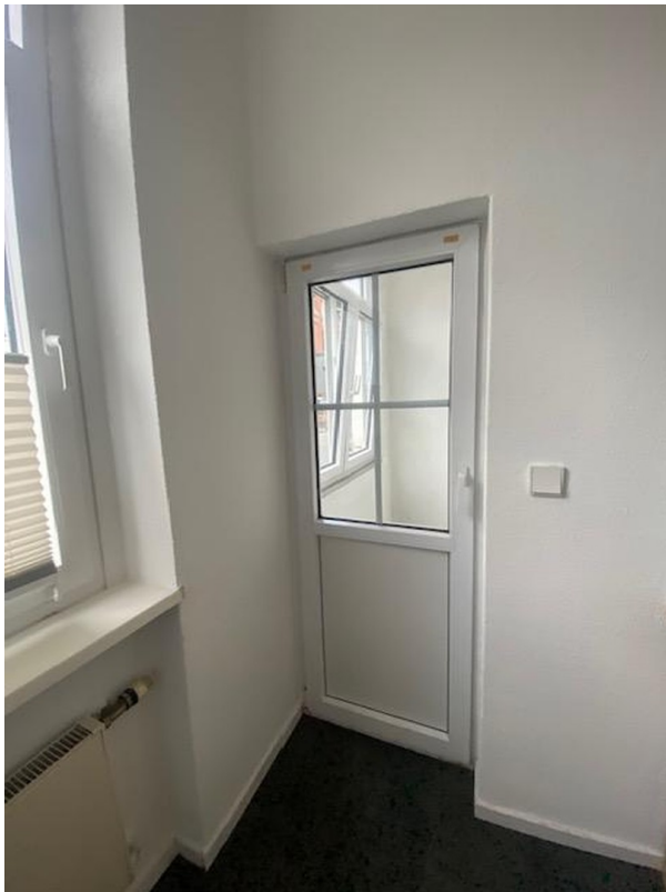
Austritt (ehemalige Loggia)
