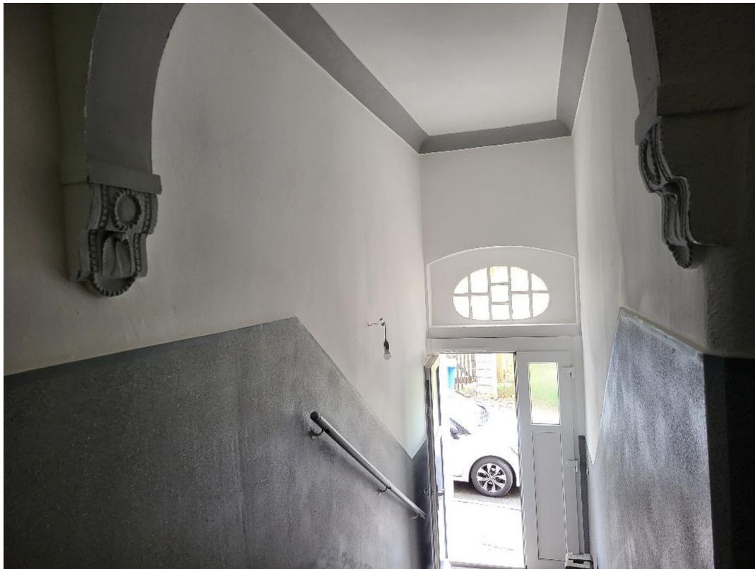
Treppenhaus, saniert - Detail
