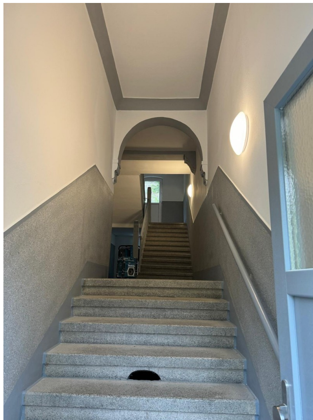
Treppenhaus, saniert - Detail
