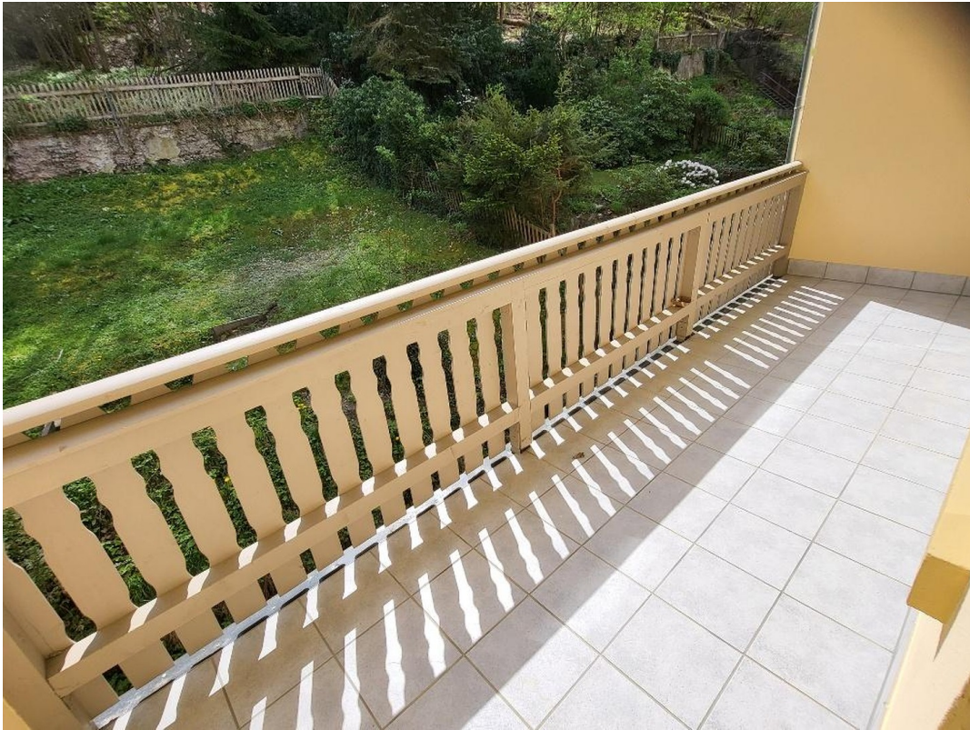
Balkon - saniert, Detail
