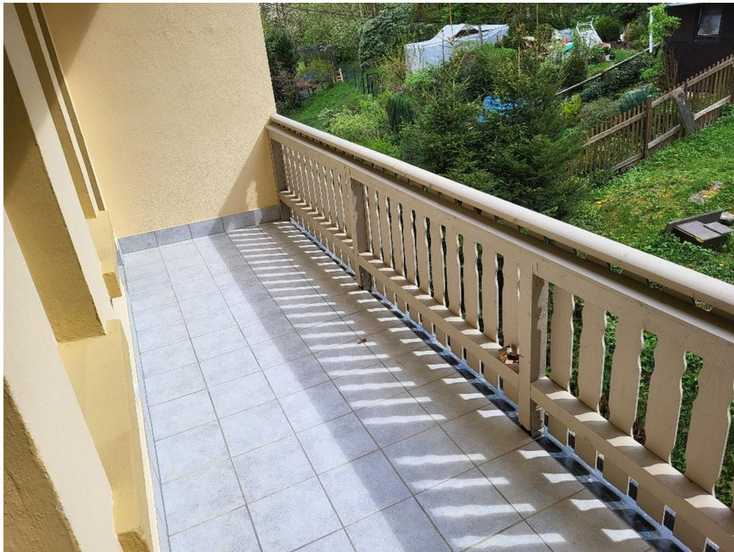
Balkon - saniert, Detail
