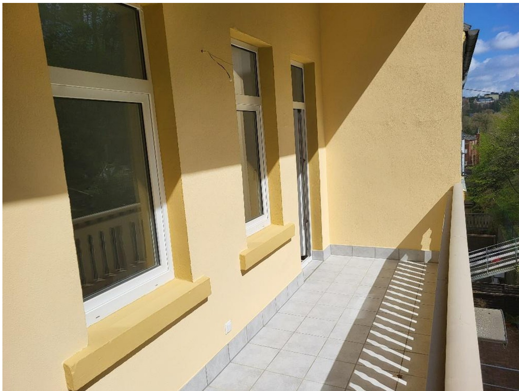
Balkon - saniert, Detail
