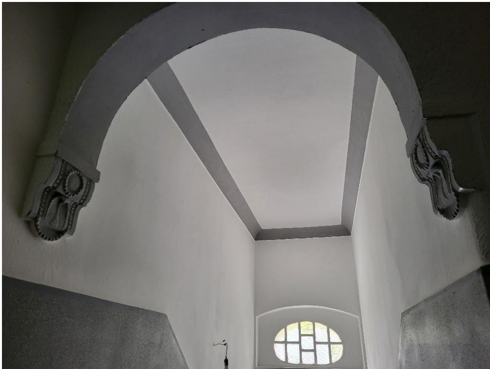
Treppenhaus, saniert - Detail
