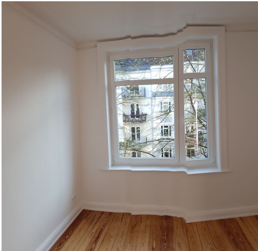
Blick aus Arbeitszimmer
