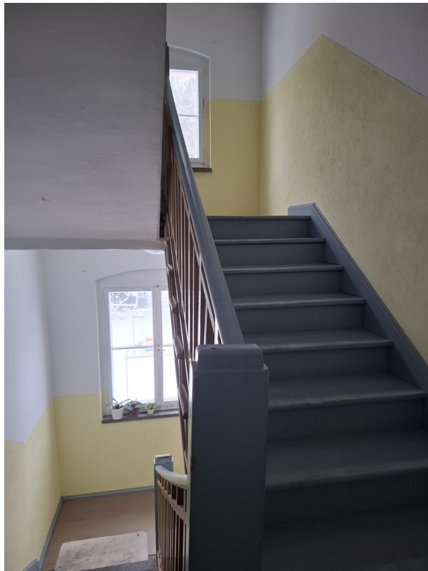
Blick im Treppenhaus
