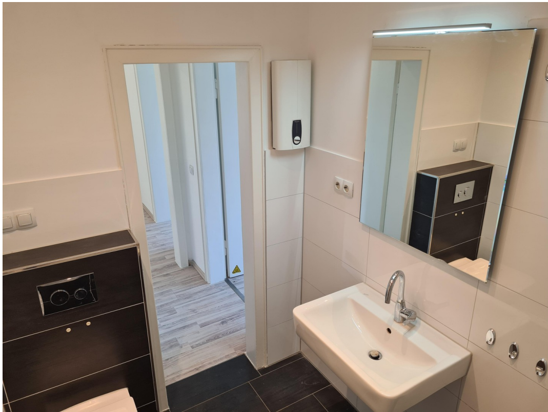
Beisp. Bad Nachbarwohnung
