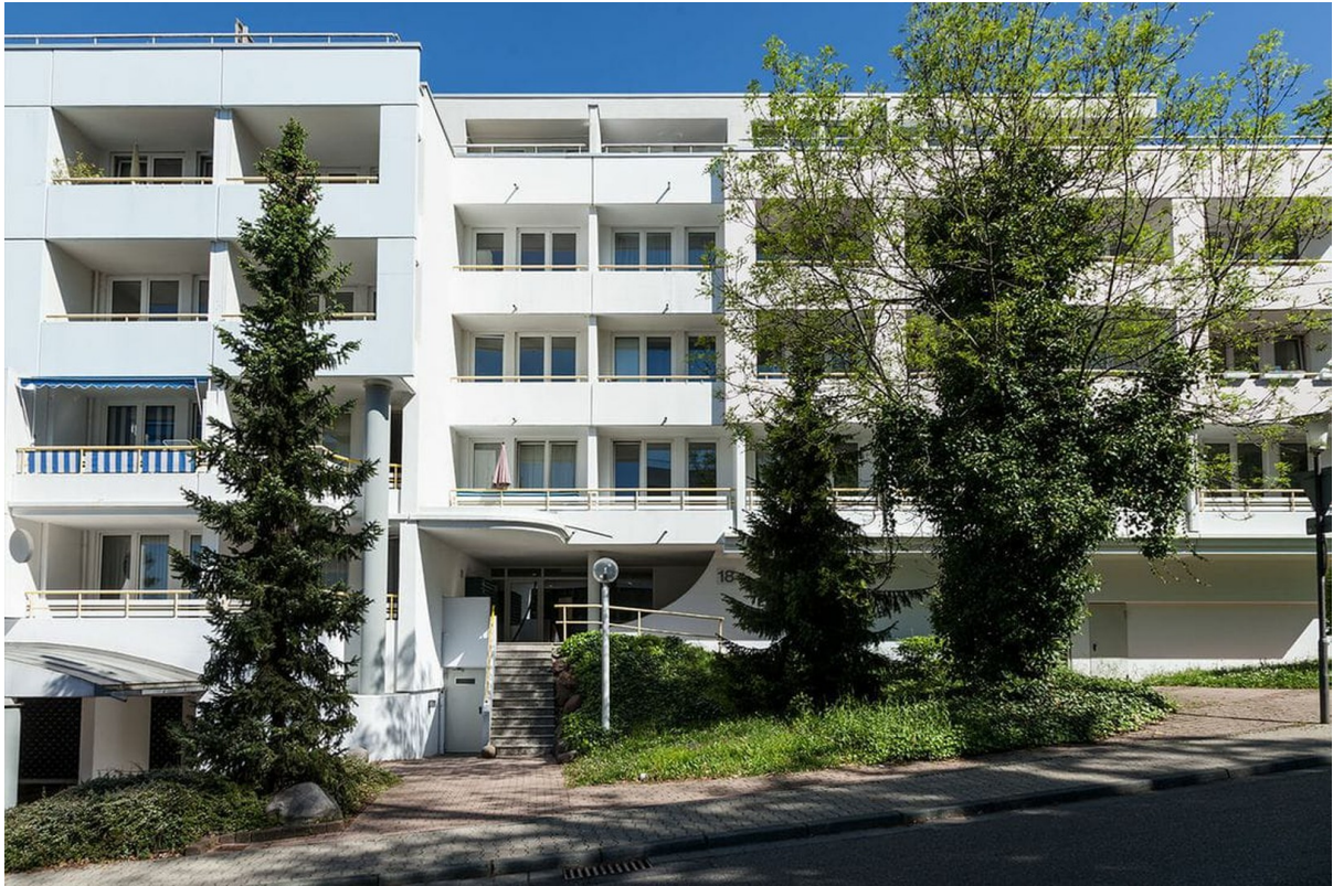
Gebäude von Außen
