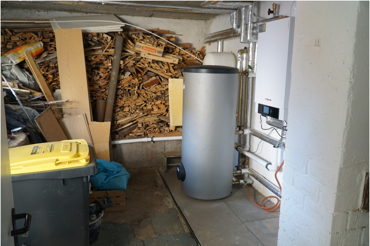
Abstell- und Technikraum
