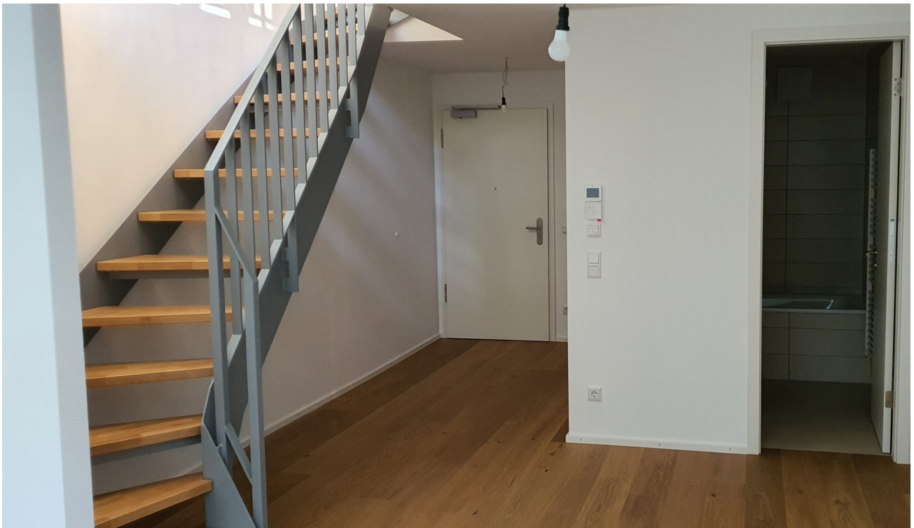
Treppe zum Souterrain
