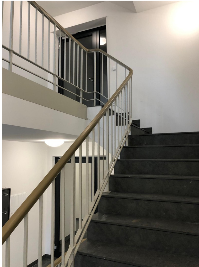
Treppenhaus-Aufgang zum 1. OG
