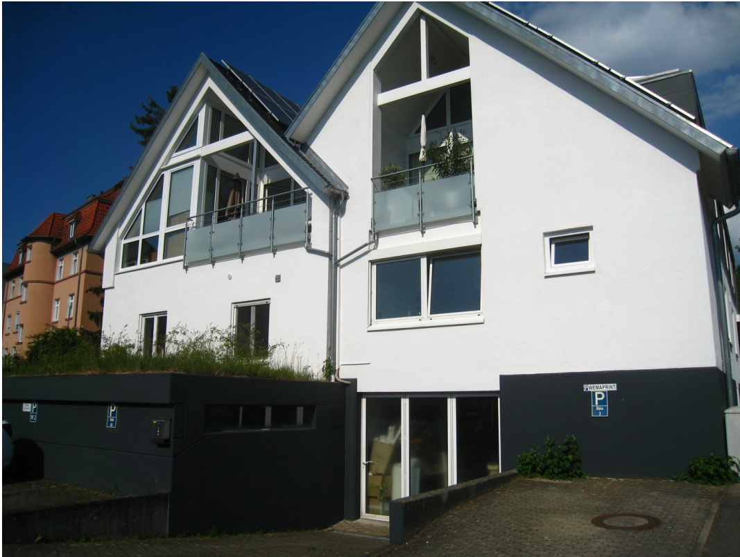
Wohnung Loggia rechts
