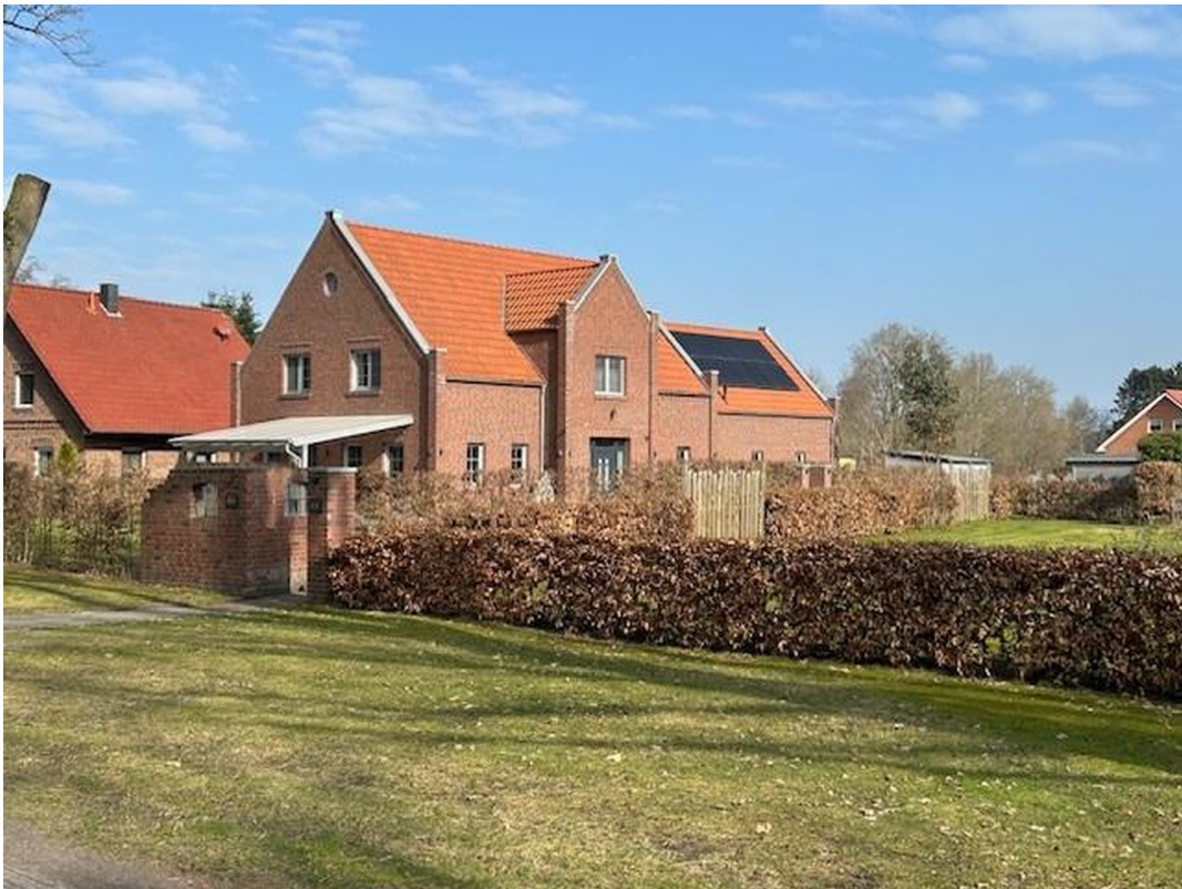
Seitliche Frontansicht Kanal
