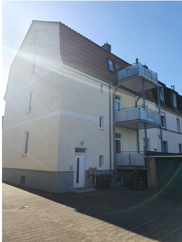
Ansicht Rückseite Gebäude
