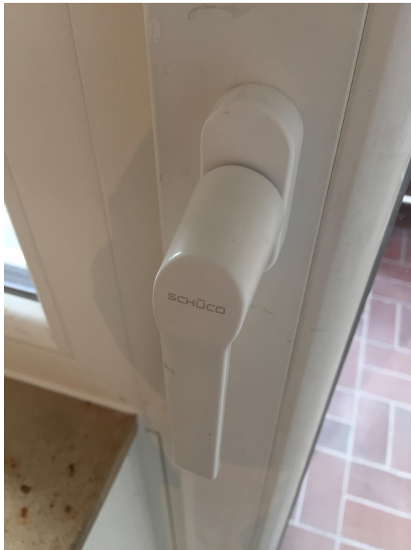
neue 3-fach verglaste Fenster
