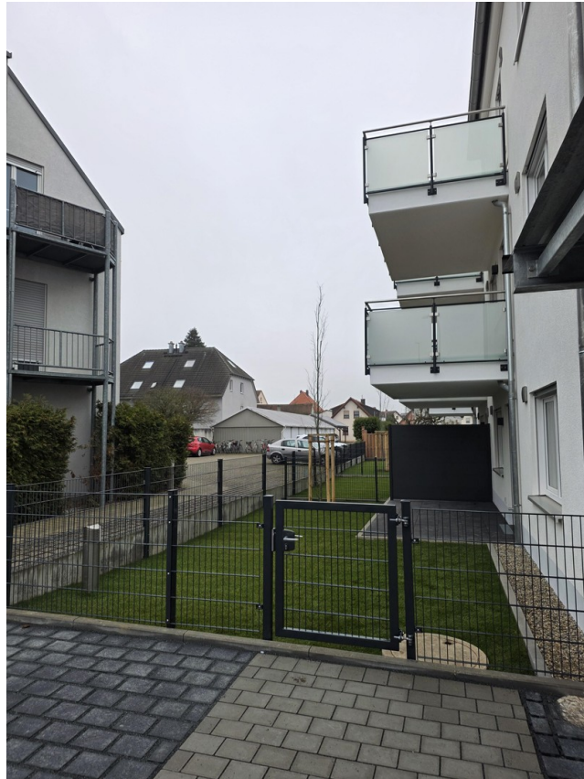
Balkon von außen
