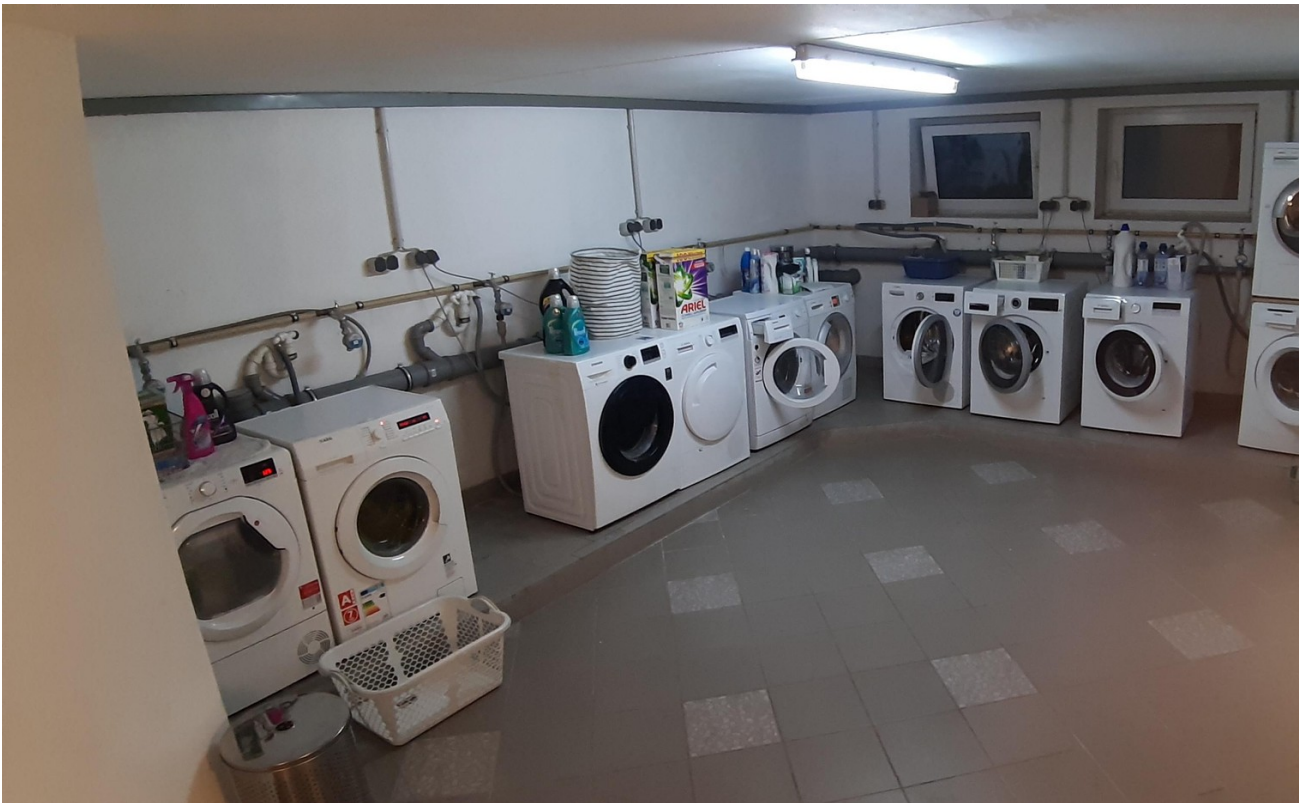
Waschmaschinenraum im Keller
