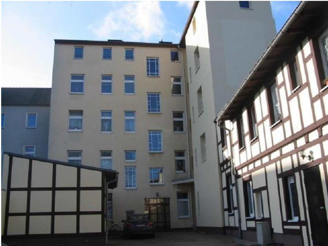
Gebäude von hinten
